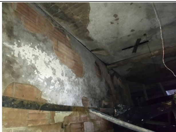
Fotografía 3 y 4. Desprendimiento de pañetes en muros de primer nivel y placa de entrepiso cara inferior predio (P1) (7/06/2023)
