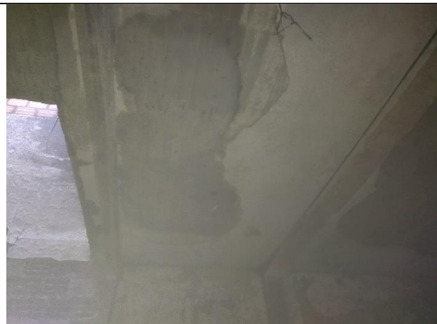
Fotografía 3 y 4. Desprendimiento de pañetes en muros de primer nivel y placa de entrepiso cara inferior predio (P1) (7/06/2023)
