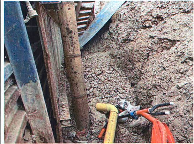
Fotos 3 y 4. Vista del talud de corte localizado al interior de la vivienda del lote evaluado y del desprendimiento de material registrado.
