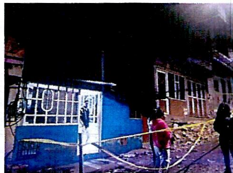
Fotografía No. 2. Vista general de la edificación del P2
