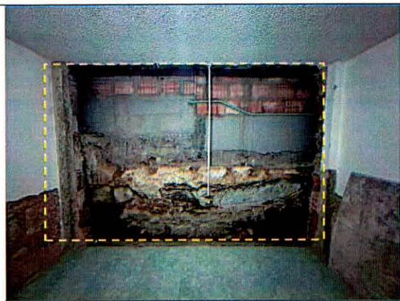
Fotografía 4. Condiciones de humedad del relleno de P2 visto desde P1
