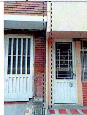
Fotografía 15. Separación de la edificación de P1 respecto a las edificaciones contiguas.
