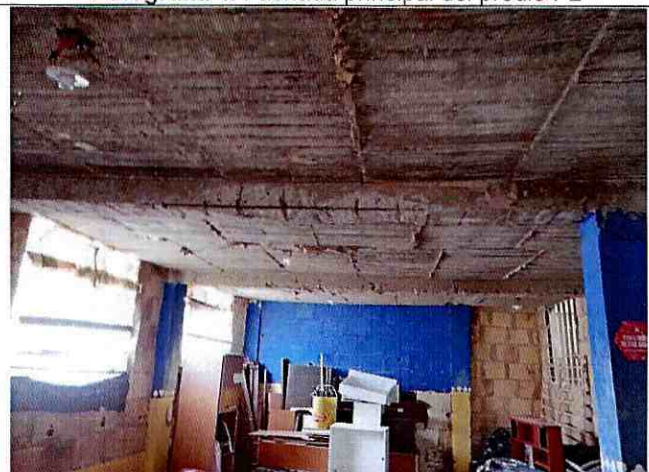
Fotografía 6. Acero de refuerzo expuesto en vigas del predio P2
