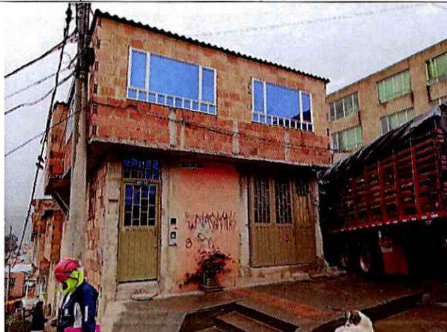
Fotografía 4. Fachada principal del predio P2
