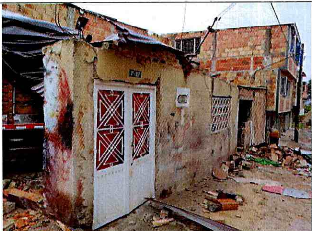
Fotografía 9. Muros del costado norte del predio P1
