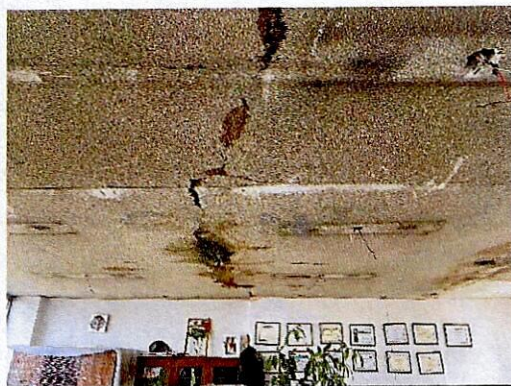
Fotografías 5 y 6. Grietas, desprendimientos y manchas de humedad en cara inferior de placa de entepiso oficina 1201 predio evaluado.
