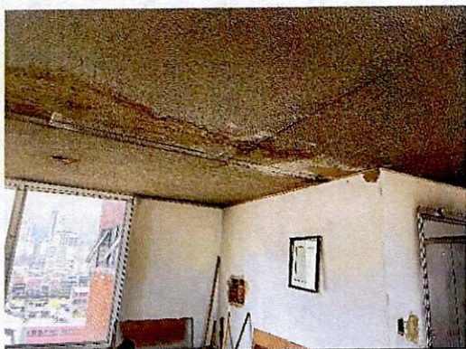
Fotografías 5 y 6. Grietas, desprendimientos y manchas de humedad en cara inferior de placa de entepiso oficina 1201 predio evaluado.
