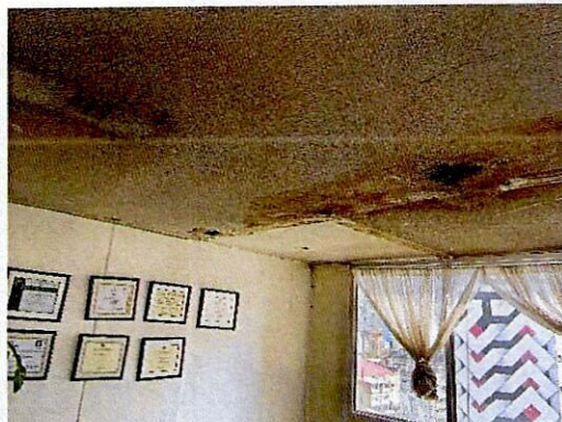
Fotografías 3 y 4. Grietas, desprendimientos y manchas de humedad en cara inferior de placa de entepiso oficina 1201 predio evaluado.
