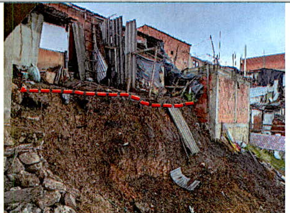
Fotografía No. 4. Vista de la Carrera 13 H en la parte alta del talud inspeccionado.
