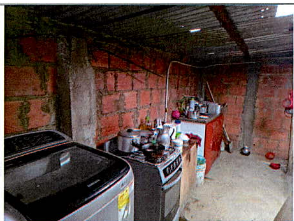
Fotografía No. 6. Vista del costado oriental de la vivienda donde no se evidencian afectaciones.
