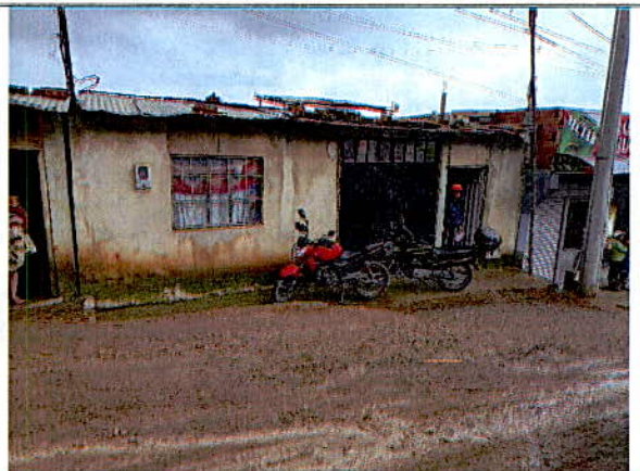
Fotografía No. 2. Vista de la vivienda emplazada en el predio evaluado.
