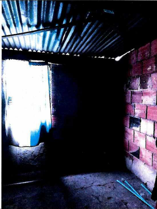
Fotografía 7. Vista del cuarto nivel de la edificación.
