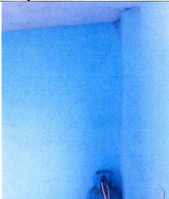
Fotografía 3 y 4. Fisuras y humedades en muros perimetrales y divisorios del segundo nivel.
