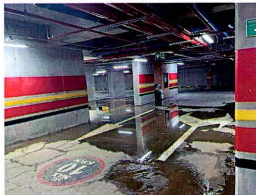
Fotografías 5 y 6. Empozamiento de agua a nivel de sótanos del predio evaluado.
