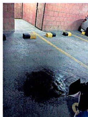
Fotografías 9 y 10. Empozamiento de agua a nivel de sótanos del predio evaluado.
