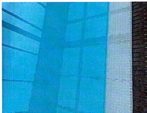
Fotografías 17 y 18. Levantamiento en membrana piscina localizada en el predio evaluado.
