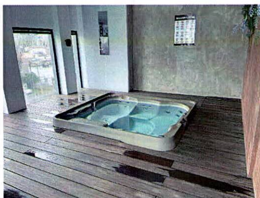
Fotografía 19. Daño en el circuito eléctrico de jacuzzi localizado en el predio evaluado
