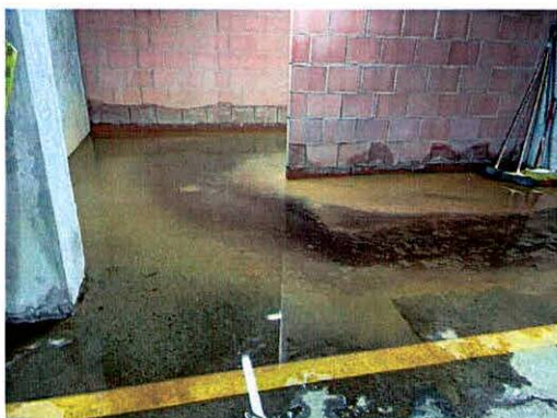
Fotografías 9 y 10. Empozamiento de agua a nivel de sótanos del predio evaluado.
