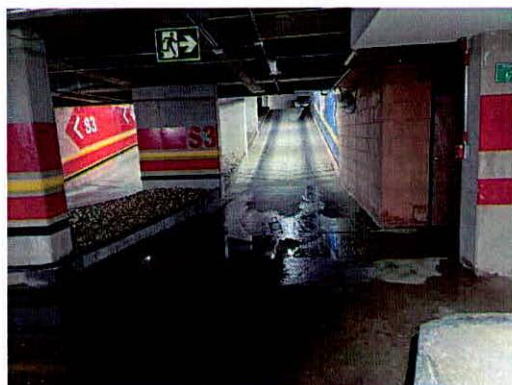
Fotografías 5 y 6. Empozamiento de agua a nivel de sótanos del predio evaluado.
