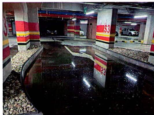
Fotografías 7 y 8. Empozamiento de agua a nivel de sótanos del predio evaluado.
