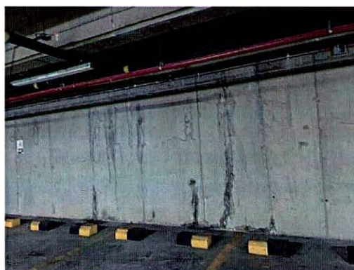
Fotografías 11 y 12. Manchas de humedad en muros perimetrales a nivel de sótanos del predio evaluado.
