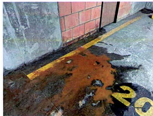
Fotografías 7 y 8. Empozamiento de agua a nivel de sótanos del predio evaluado.
