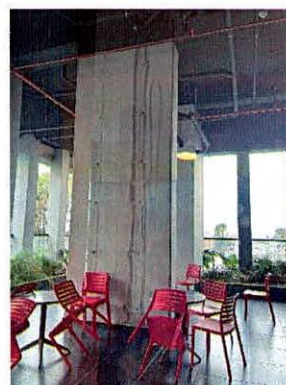
Fotografía 14. Filtraciones en columna primer nivel del predio evaluado.
