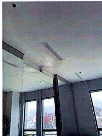
Fotografías 15 y 16. Manchas de humedad en drywall primer nivel predio evaluado.
