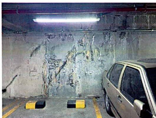
Fotografía 13. Manchas de humedad en muros perimetrales a nivel de sótanos del predio evaluado.
