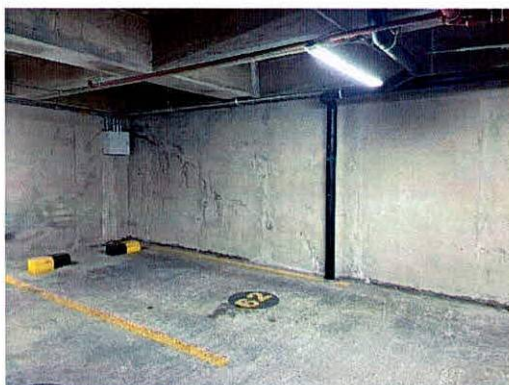
Fotografías 11 y 12. Manchas de humedad en muros perimetrales a nivel de sótanos del predio evaluado.
