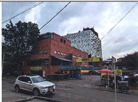
Fotografía No. 2. Vista de la edificación emplazada en el predio evaluado.
