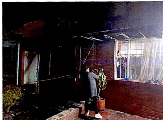
Fotografía 7. Vivienda emplazada en P3.
