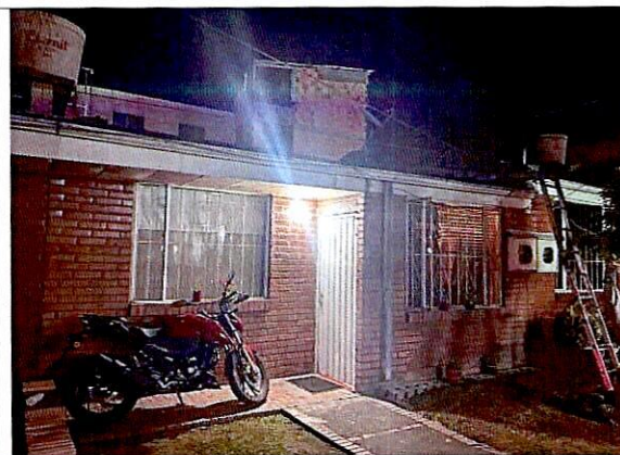
Fotografía 9. Vivienda emplazada en P1.
