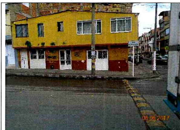
Fotografía 1. Vivienda de la Calle 60 Sur No. 22G – 05 en el Sector Catastral Chircal Sur, de la Localidad de Ciudad Bolívar al frente se observa un reductor de velocidad.
