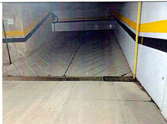
Fotografía 3. Vista en el sector de los sótanos. Muros con recubrimiento liviano.
