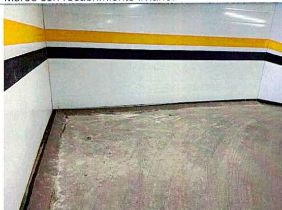
Fotografía 5. Implementación de canaletas para captación de aguas en la parte inferior de algunos muros perimetrales.
