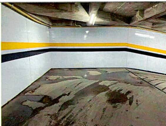
Fotografía 4. Muros con recubrimiento liviano sobre los muros perimetrales del sótano.
