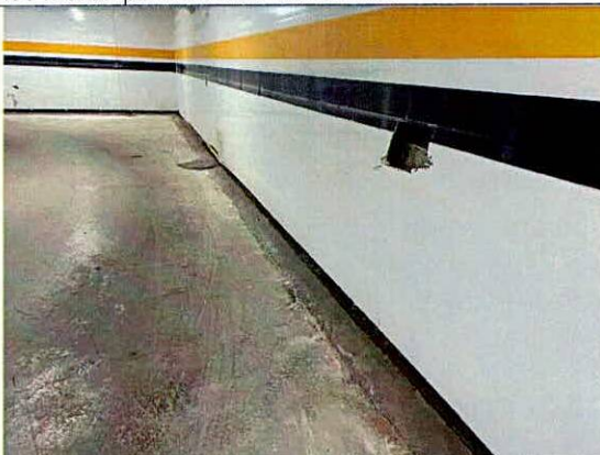
Fotografía 6. Implementación de canaletas para captación de aguas en la parte inferior de algunos muros perimetrales.
