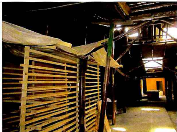
Foto 20. Apuntalamiento temporal de la cubierta.
