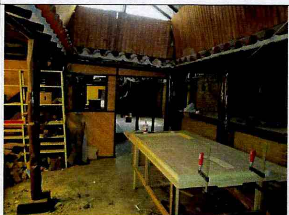
Foto 5. Vista interna de los elementos del sector frontal.
