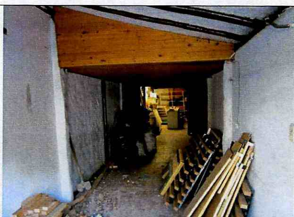
Foto 4. Muros del sector frontal de la edificación.
