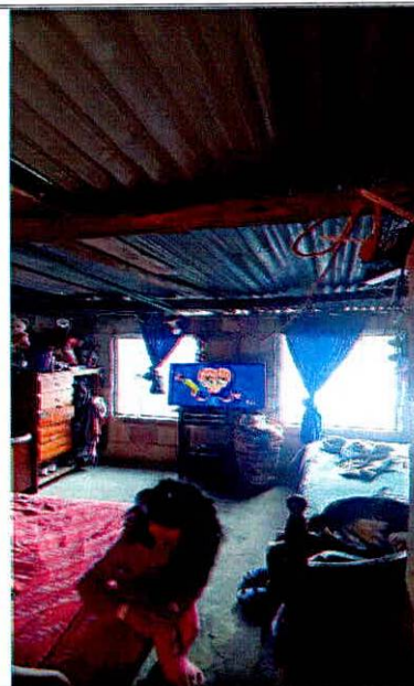
Fotografía 8. Vista del interior de la vivienda del predio de la Calle 138 B Sur No. 14 F – 05. Se observa la habitación frontal del segundo nivel y la cubierta.
