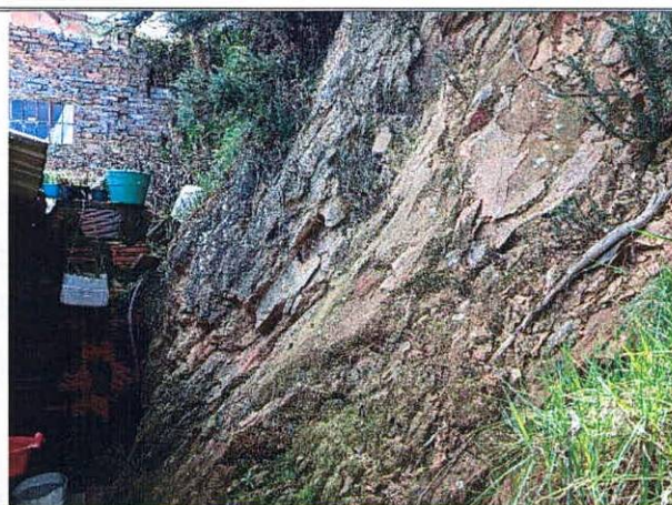
Fotografía No. 4. Vista del talud localizado en el costado oriental del predio evaluado y parte posterior de la vivienda.
