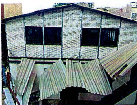
Fotografía 11. Fachada predio P3.
