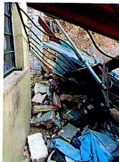
Fotografías 7 y 8. Colapso de muro de cerramiento afectando zona de patio del predio P2 y zona de acceso al predio P3.
