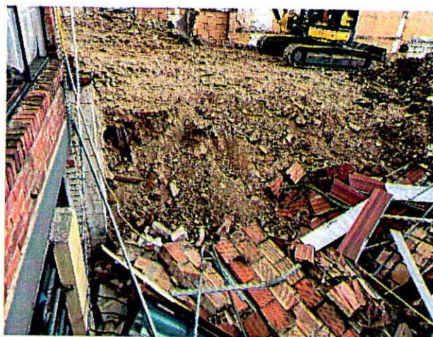
Fotografías 7 y 8. Colapso de muro de cerramiento afectando zona de patio del predio P2 y zona de acceso al predio P3.
