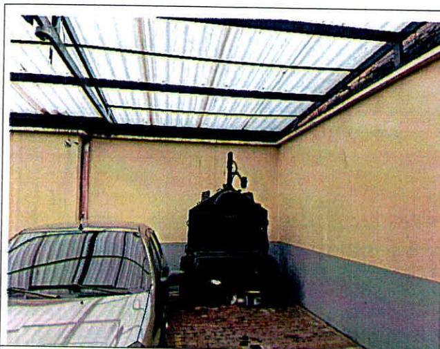
Fotografía 17. Interior primer nivel predio P5.
