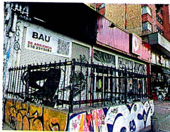
Fotografía 18. Fachada predio P6.
