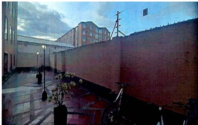
Fotografía 3. Cerramiento del primer nivel del predio P2, colindante con el predio P1.
