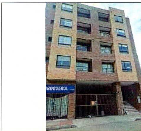
Fotografía 2. Fachada principal del Edificio Kolina de Santa Inés en el predio P1.
