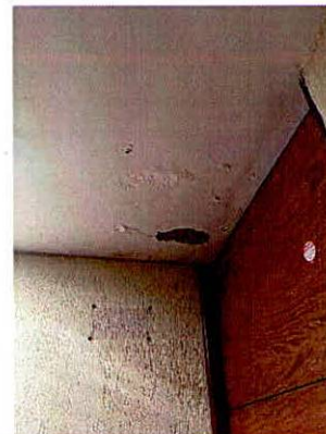
Fotografía 16. Humedades en muros interiores y acabados de placa de entepiso evaluado.
