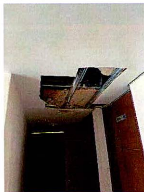
Fotografía 15. Desprendimientos de drywall zonas comunes del predio evaluado.
