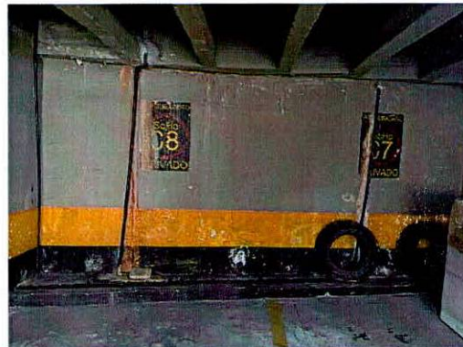
Fotografías 11 y 12. Humedades observadas a nivel de sótanos predio evaluado.
