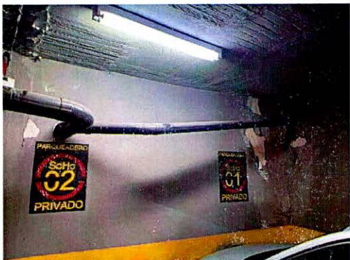
Fotografías 11 y 12. Humedades observadas a nivel de sótanos predio evaluado.
