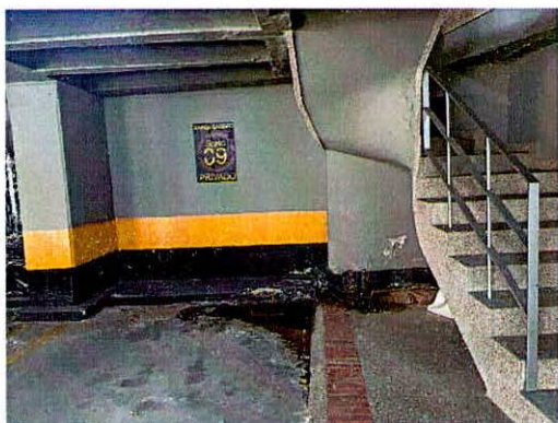
Fotografía 13. Humedades observadas a nivel de sótanos predio evaluado.
