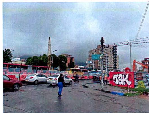
Fotografía 10. Obras de intervención Empresa Metro de Bogotá Avenida Caracas a la altura de la Calle 72A.
