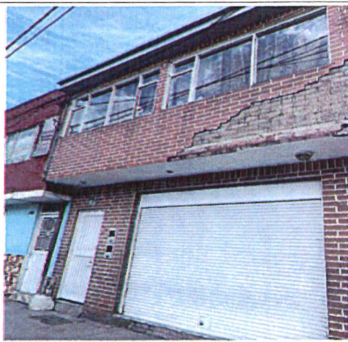
Foto 2. Vista fachada de la vivienda Carrera 56 #17B-38
