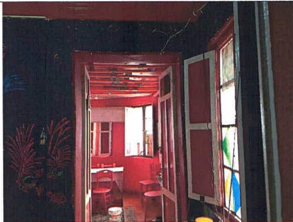
Fotografía 8. Estado de la zona de comedor, primer nivel de la vivienda.
