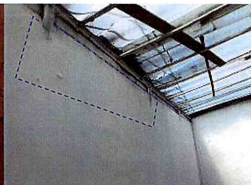
Fotografías 11 y 12. Manchas de humedad en muros perimetrales e interiores predio P2.
