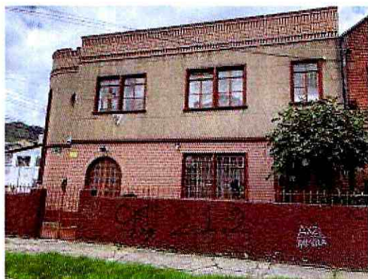
Fotografía 14. Fachada predio P4.
