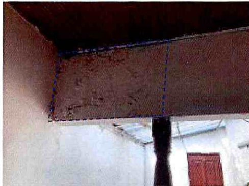
Fotografías 9 y 10. Manchas de humedad en muros perimetrales e interiores predio P2.
