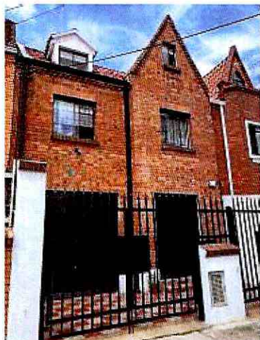
Fotografía 13. Fachada predio P3.
