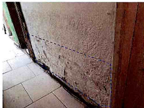
Fotografías 11 y 12. Manchas de humedad en muros perimetrales e interiores predio P2.
