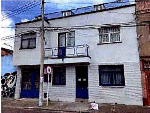
Fotografía 14. Fachada predio P5.
