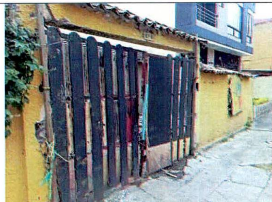
Fotografía 2. Entrada principal de la edificación.
