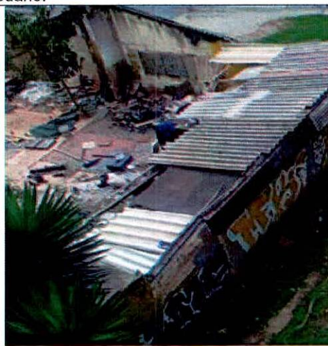
Fotografía 7. Interior de la edificación (Registro tomado petición 2024ER9270).
