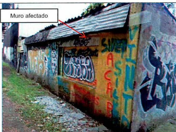
Fotografía 4. Muro perimetral del costado posterior de la edificación evaluada
