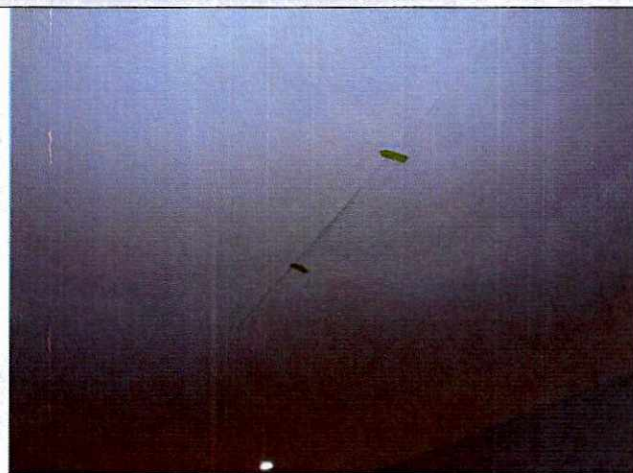
Fotografía 6. Fisura horizontal en el predio P1
