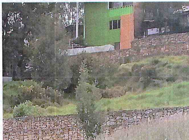
Fotos No. 3 y 4. Vista general del sector donde al parecer se han emplazado algunas construcciones de origen informal hacia la parte alta de los muros en gaviones desarrollados como parte de la adecuación del predio de la Calle 13 Sur # 14-61 Este.
