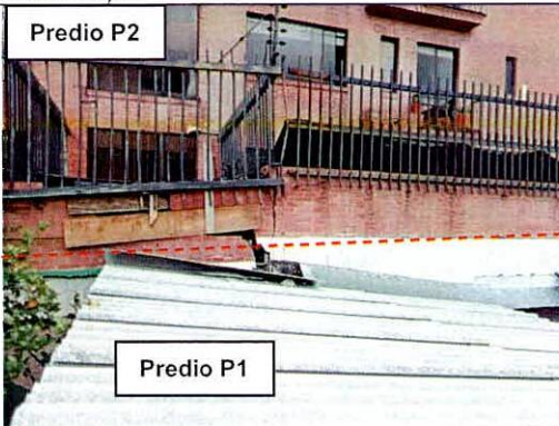
Fotografía 10. Daños en la estructura del muro de cerramiento perimetral del costado oriental del predio P2 (visto desde P1).
