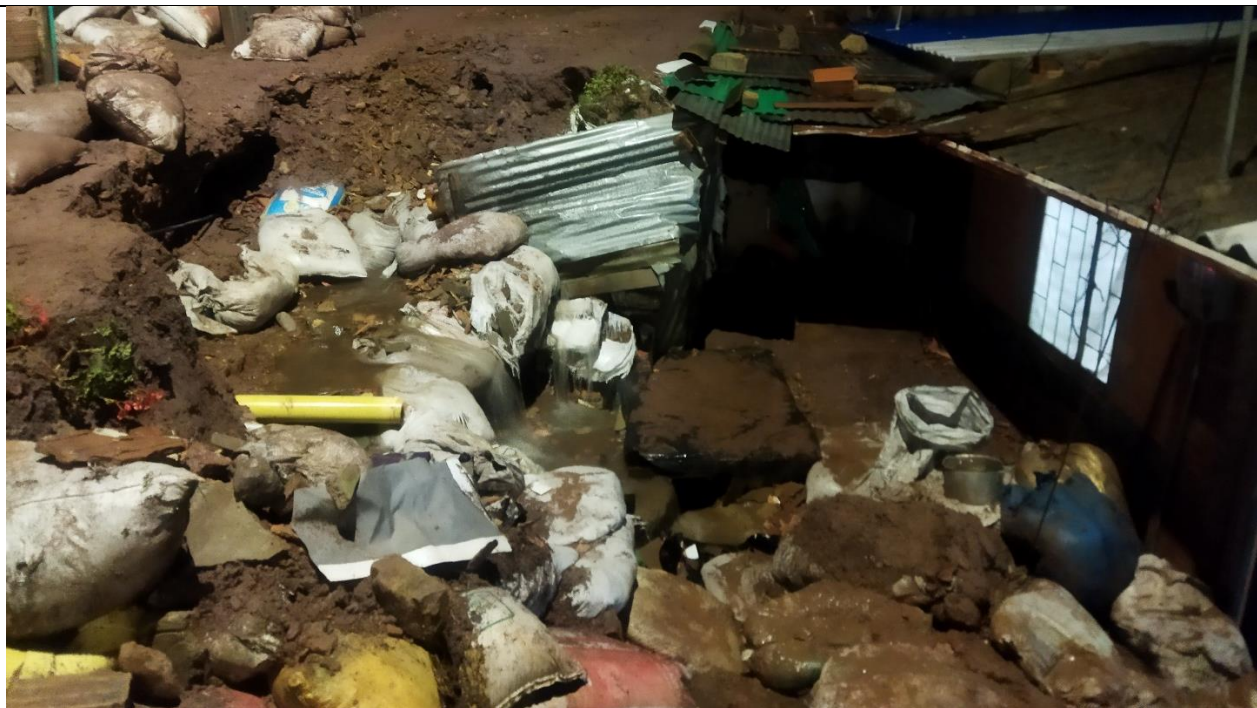
Fotografía 1 Vista general vía y vivienda Predio (P1) (19/11/2023)
