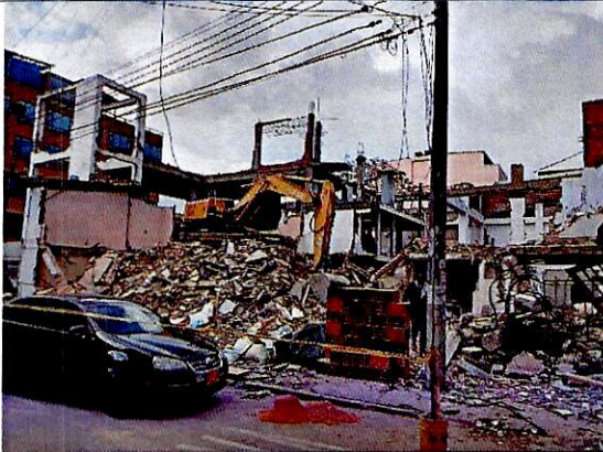
Fotografía 3. Avance de las labores de demolición en costado oriental del predio evaluado.
