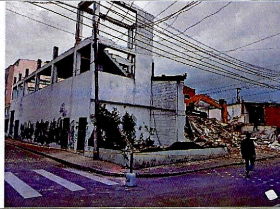
Fotografía 4. Avance de las labores de demolición en costado occidental y Sur del predio evaluado.
