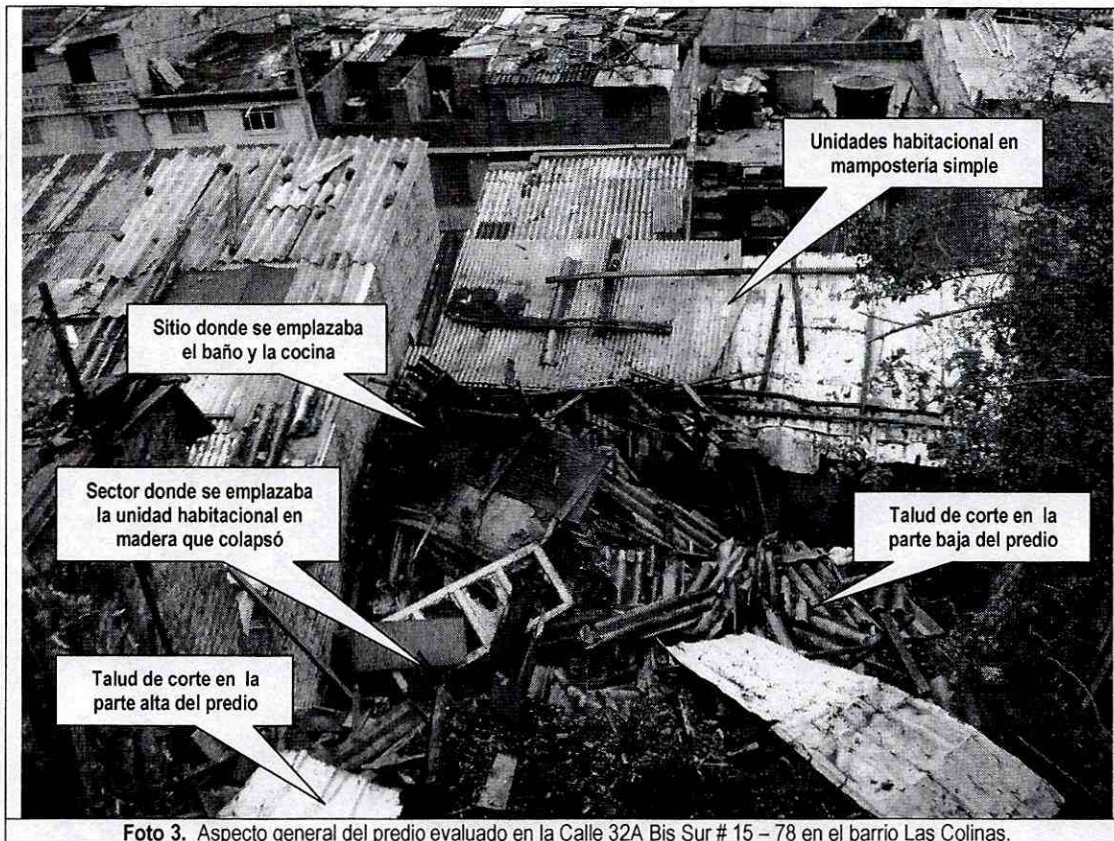
Foto 3. Aspecto general del predio evaluado en la Calle 32A Bis Sur # 15 – 78 en el barrio Las Colinas.
