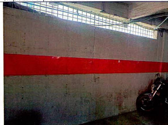
Fotografía 3. Muro colindante con lote de gran extensión.
