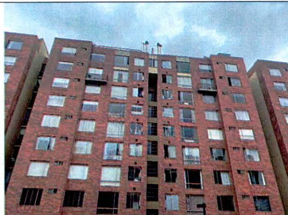
Fotografía 2. Torres de apartamentos de 10 niveles.
