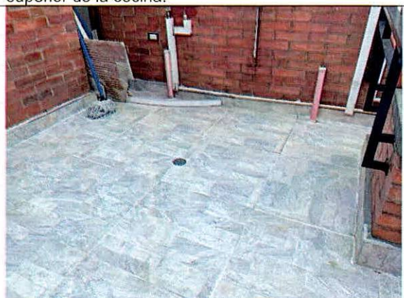
Fotografía 10. Terraza ubicada en el segundo nivel del Apto 1001, Torre 5. Sin evidencia de daños ni encharcamientos.
