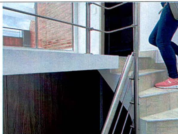
Fotografía 4. Vista al interior del Apto 1001, Torre 5. Sector escaleras.
