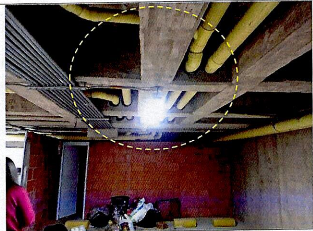
Fotografía 4. Perforación de elementos estructurales en nivel de sótano.
