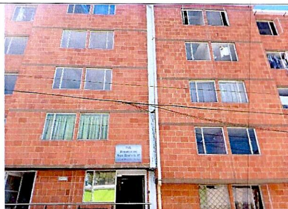
Fotografía 2. Conjunto residencial de la CL 61 SUR 15C 55 ESTE
