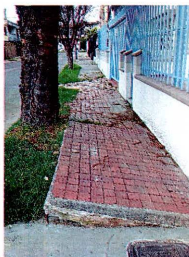
Fotografías 6 y 7. Daños del sendero peatonal localizado al costado occidental de los predios P1 y P2.
