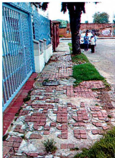
Fotografías 4 y 5. Daños del sendero peatonal localizado al costado occidental de los predios P1 y P2.
