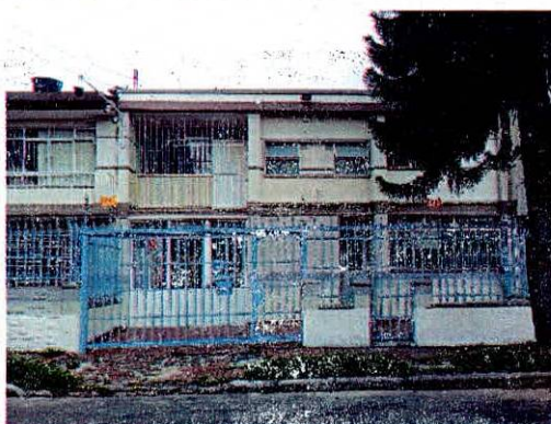
Fotografía 10. Fachada predio P2.
