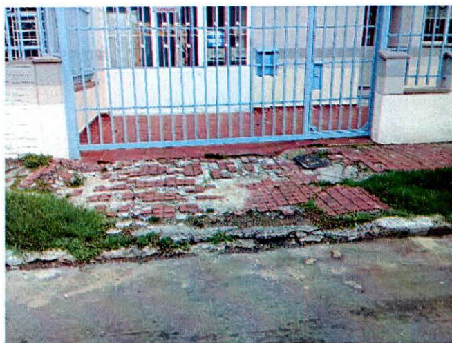
Fotografías 4 y 5. Daños del sendero peatonal localizado al costado occidental de los predios P1 y P2.
