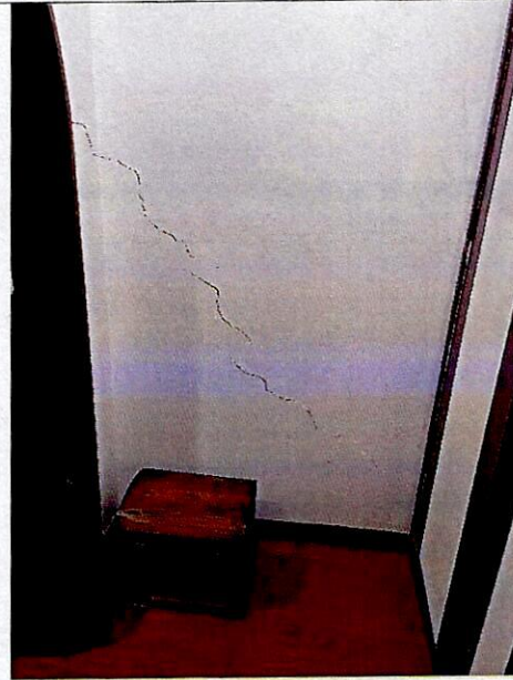
Fotografías 11 y 12. Fisuras y grietas en muros interiores de zona de patio apartamento 101 predio P1 (Fotografía tomada el 04 de enero de 2024)
