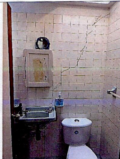
Fotografías 21 y 22 . Fisuras en acabados de baldosas de zona de patio y baños apartamento 102 predio P1 (Fotografía tomada el 04 de enero de 2024)
