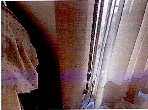
Fotografías 27 y28. Fisuras en muros divisorios apartamento 102 predio P1 (Fotografía tomada el 04 de enero de 2024)
