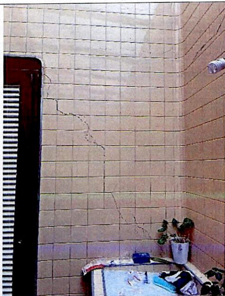
Fotografías 5 y 6. Fisuras en acabados de muros zona de patio y baños apartamento 101 predio P1 (Fotografía tomada el 04 de enero de 2024)
