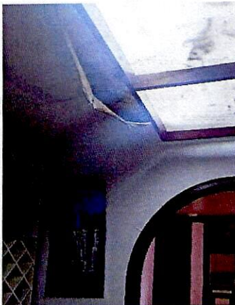
Fotografía 29. Humedad en placas de contrapiso predio P1 apartamento 102 predio P1 (Fotografía tomada del diagnóstico técnico DI-18781)
