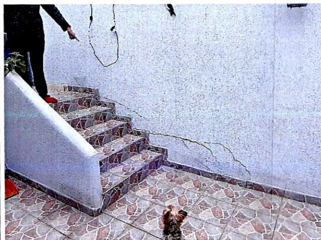
Fotografías 9 y 10. Grietas en muros interiores de zona de patio apartamento 101 predio P1 (Fotografía tomada el 04 de enero de 2024)
