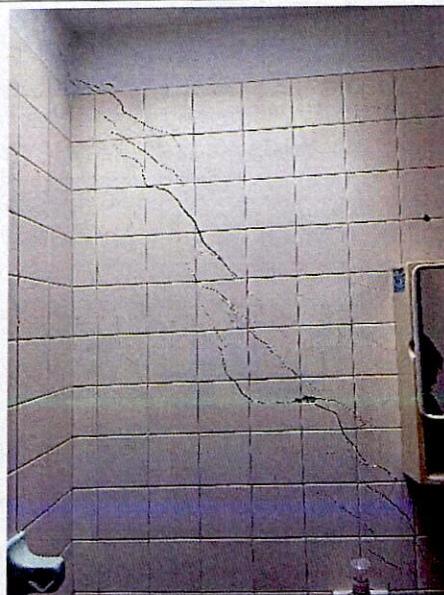
Fotografías 5 y 6. Fisuras en acabados de muros zona de patio y baños apartamento 101 predio P1 (Fotografía tomada el 04 de enero de 2024)
