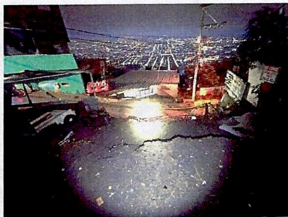
Fotografía 6. Parte alta del deslizamiento, vista desde zonas verdes de los predios P1 y P2
