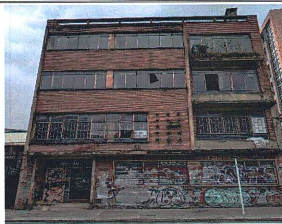
Fotografía No. 2. Vista de la edificación emplazada en el predio evaluado.
