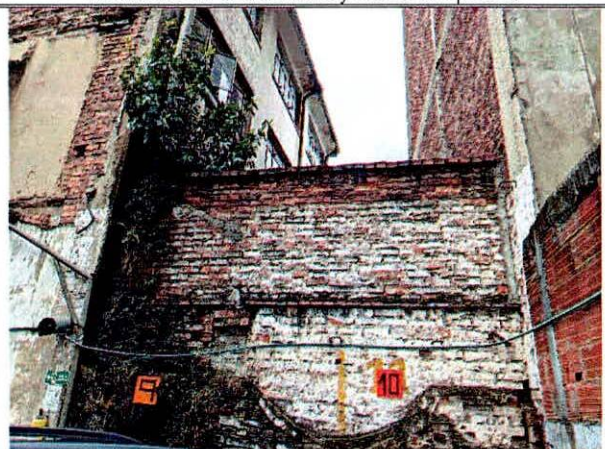
Fotografía No. 10. Vista de los muros perimetrales colindantes con el parqueadero de la Carrera 5 No. 22 – 61.
