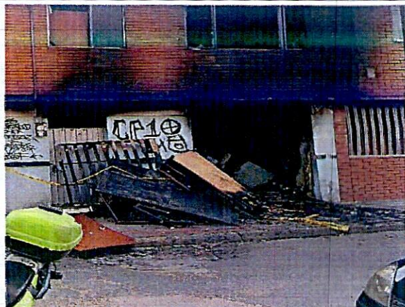
Fotografía No. 2. Vista general de muebles en el garaje.
