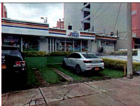
Fotografía 2. Acceso principal a la edificación evaluada.
