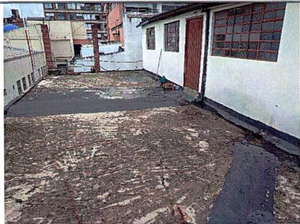
Fotografía No. 6. Vista de la terraza en el cuarto piso de la edificación evaluada.
