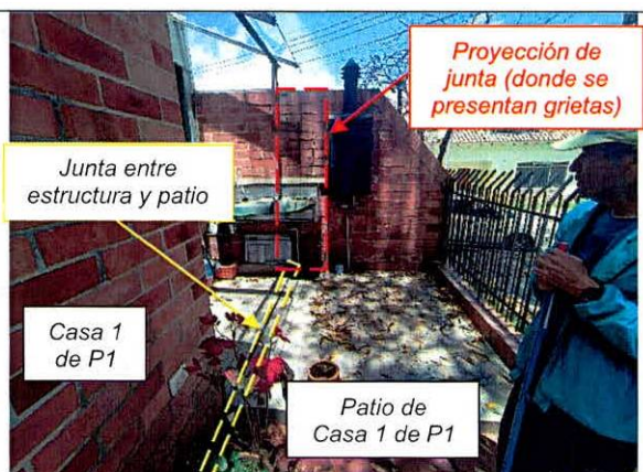
Fotografía 4. Vista de norte a sur de la disposición de las casas del costado occidental del predio P1
