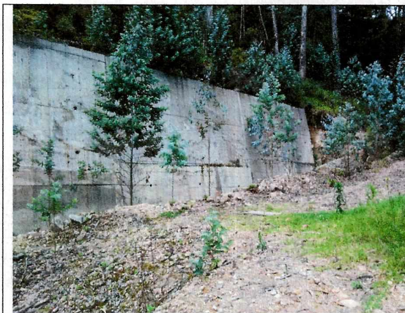
Fotografía 3. Vista de muro de contención, en costado nororiental.
