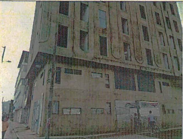
Fotografía 21. Vista de la edificación en construcción en el predio de la AC 132 No. 100 - 33.
