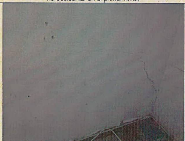
Fotografía 20. Fisura en muro perimetral en la zona nororiental en el primer nivel.
