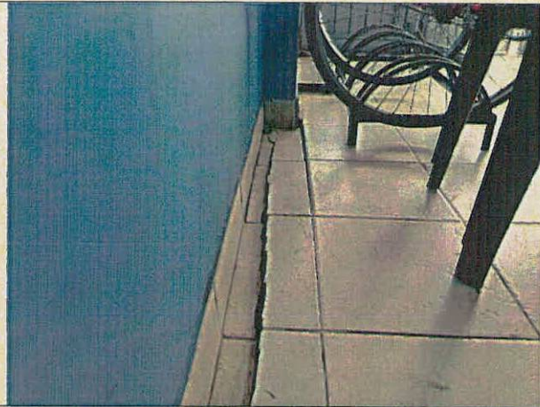
Fotografía 17. Levantamiento del piso en la zona noroccidental en el primer nivel.
