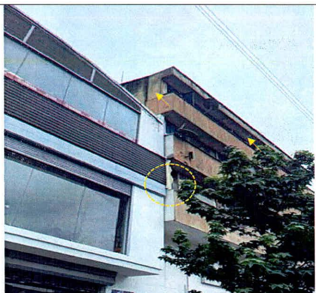
Foto 8. Zona con lámina de icopor. Y muros costado norte sin material de acabado. También obsérvese humedades
