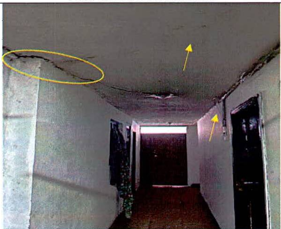
Foto 4. y 5. Humedades en dilataciones y abombamientos en material de acabado
