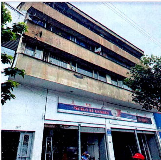
Foto 1. Vista del predio inspeccionado
