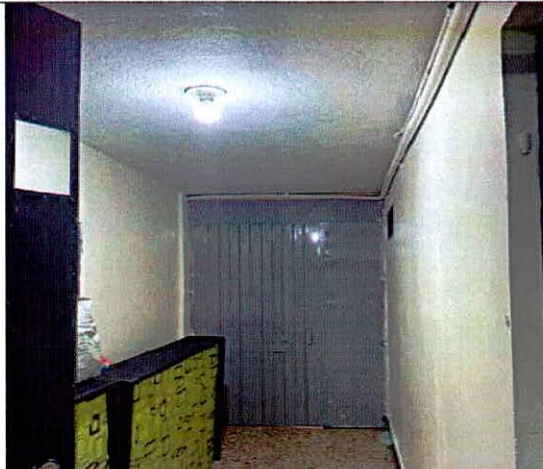
Foto 7. Áreas comunes donde no se evidencian daños visibles
