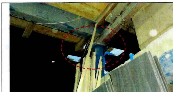
Fotografías 5 y 6. Deficiencias en algunas de uniones entre los elementos metálicos y de madera que soportan el mezzanine.
