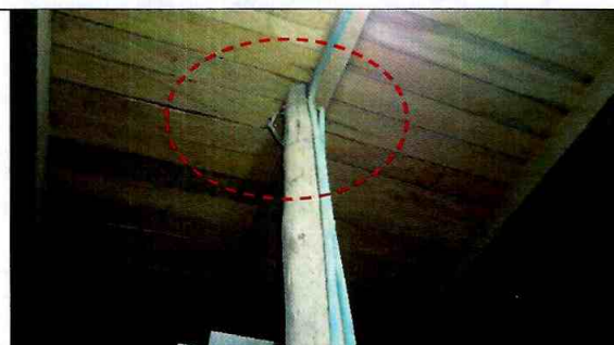
Fotografías 5 y 6. Deficiencias en algunas de uniones entre los elementos metálicos y de madera que soportan el mezzanine.
