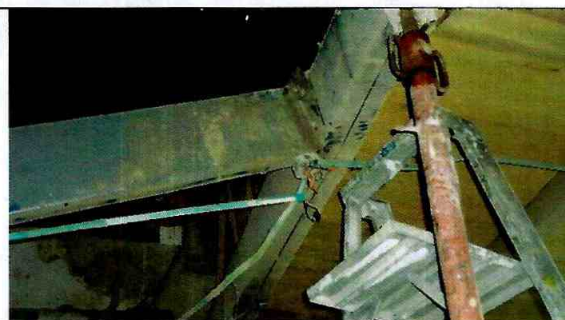
Fotografías 3 y 4. Vista del área de trabajo y bodega – unión pernada que une las dos secciones del mezzanine.
