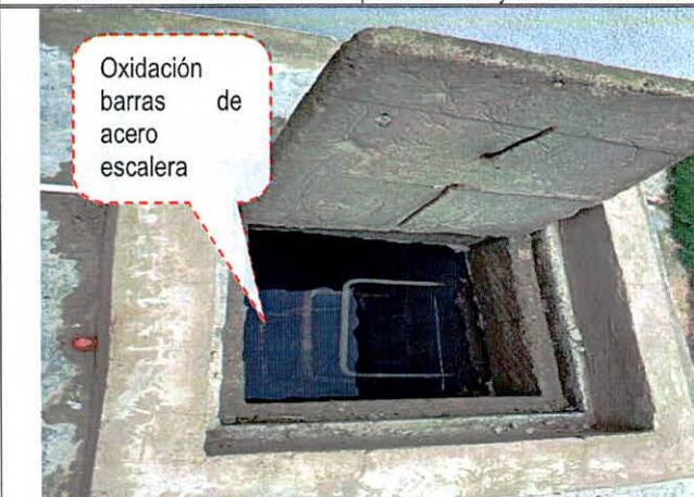
Foto No. 8. Vista al interior del tanque de reserva
