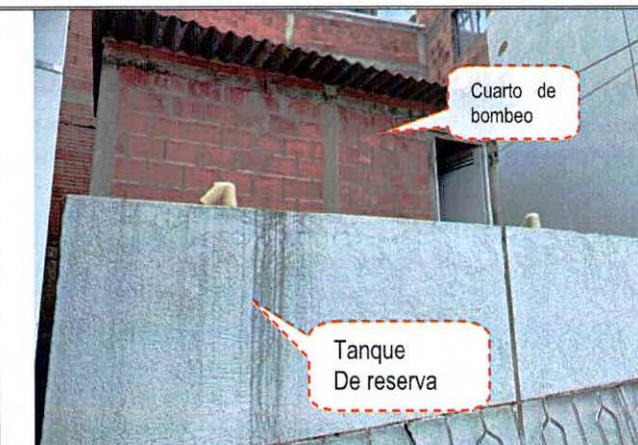
Foto No. 6. Vista frontal de tanque de reserva y cuarto de bombeo
