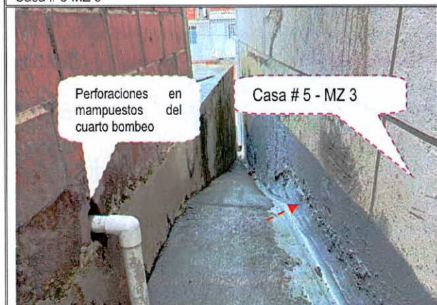
Foto No. 5. Resanes en muro perimetral externo de la Casa # 5 MZ 3
