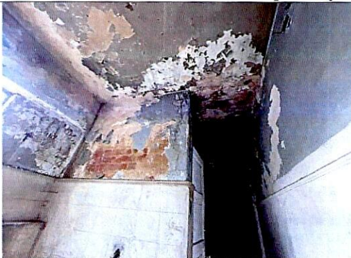
Fotografía. 3 y 4. Manchas de humedad evidencias al interior del predio
