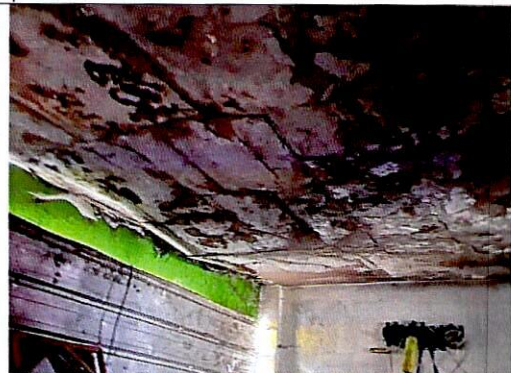
Fotografía. 3 y 4. Manchas de humedad evidencias al interior del predio
