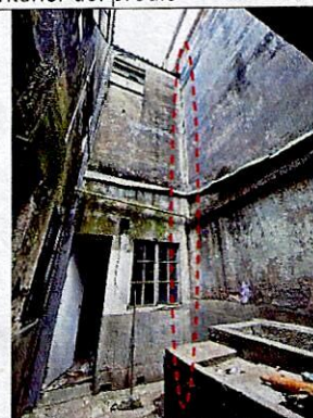
Fotografías 7 y 8. Fisuras identificadas en el muro oriental del predio
