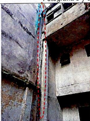
Fotografías 7 y 8. Fisuras identificadas en el muro oriental del predio
