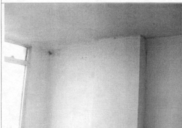
Foto 3. Muros de segundo piso
