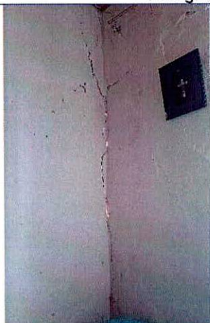
Fotografía 5 y 6. Grietas en el muro perimetral del costado sur del predio P1, en la zona de la habitación principal
